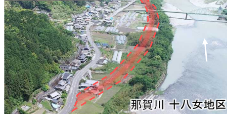
河川堤防整備
