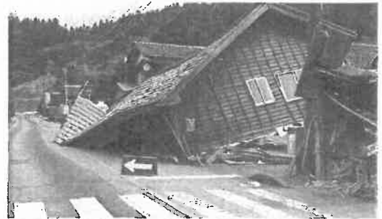
能登半島地震の民家被害の様子(輪島市) NPO法人アユートネットワーク(徳島市) 写真提供
