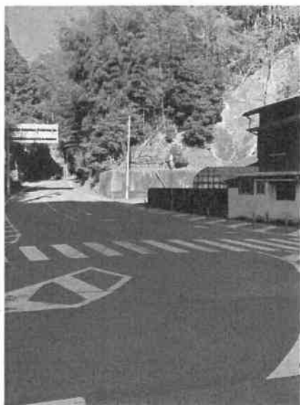
小松島櫛淵 三叉路改良
