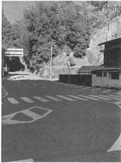
小松島櫛淵 三叉路改良
