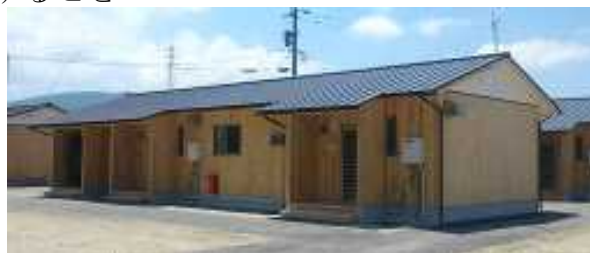
木造応急仮設住宅
