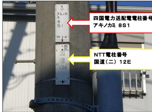
電柱所有者の電柱札(電柱番号)が上側に取付
