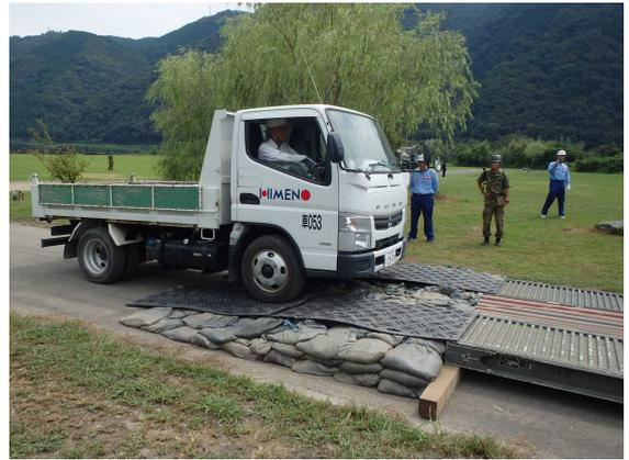
写真 土のうによる段差解消訓練
