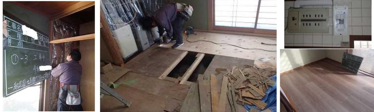
診断結果より壁補強10ヶ所と劣化による1階和室床下地合板張替えと広縁床張替え及び地震時に自動的に主幹ブレーカーを遮断する感震ブレーカーを取付けました。これにより評点を安全なレベルに改善し、住んでいる方のご要望に沿い環境にやさしい工事を行いました。また、家具の固定金物取付を7ヶ所行いました。
