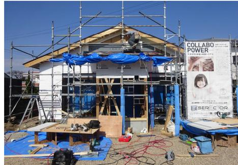
木造平屋の耐震性に問題があった住宅を評価1.0以上に改善。経年劣化した外装材を耐震リフォームと併せて貼替え、耐震性の強化と共に新築のような外観へ生まれ変わった。また、玄関ドア前には目隠しを兼ねた耐震壁を設置し、外からの視線にも配慮した。
