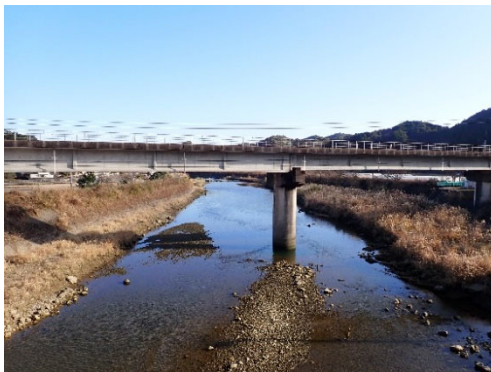
河口から約 0.9km 上流
