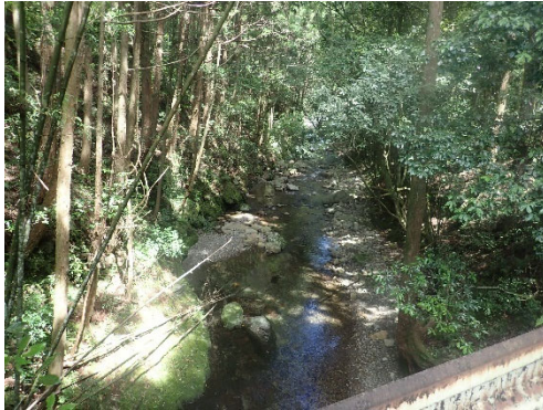
河口から約 10.0km 上流
