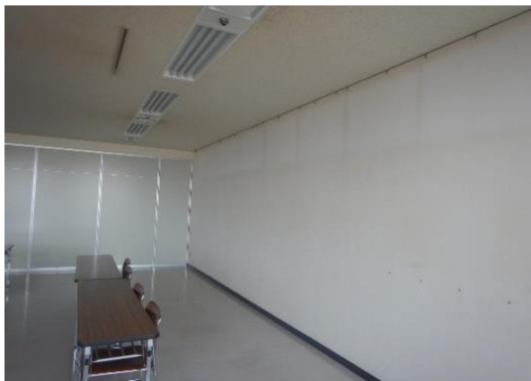
西側壁（会議室1102）
