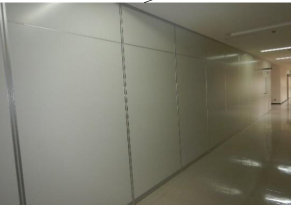
廊下側壁 （会議室1102）
