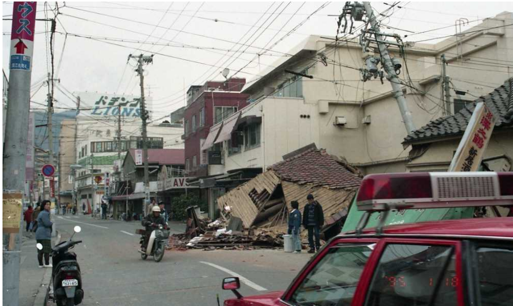
写真 電柱の破損事例
