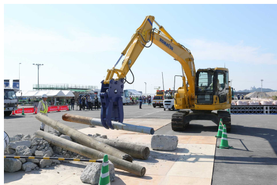
写真 ガレキ除去訓練状況
