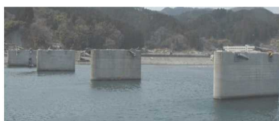
図 東日本地震における津波による落橋の被害状況
