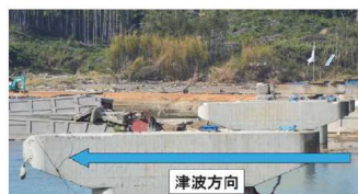
図 東日本地震における津波による落橋の被害状況
