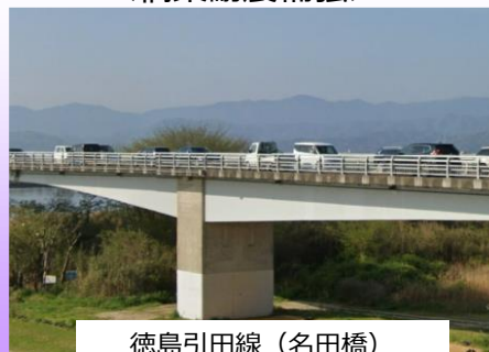
徳島引田線 (名田橋)
