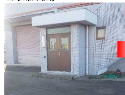
出島川排水機場
