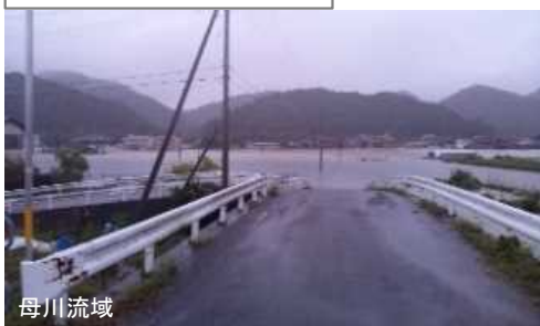
平成26年台風第12号浸水状況
