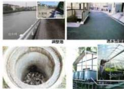
雨水貯留浸透施設の例
