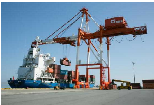
ガントリークレーン
