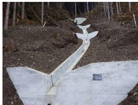
(治山ダム工・流路工：上勝町殿川内地区)
