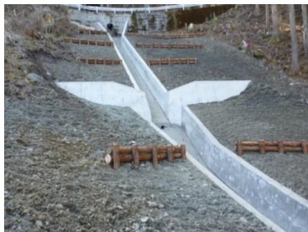
(山腹工：上勝町葛又地区)
