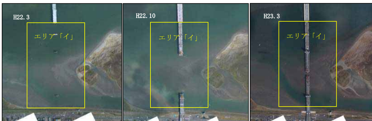
図 5-3-3-2 エリア「イ」架橋工事の進捗状況写真
