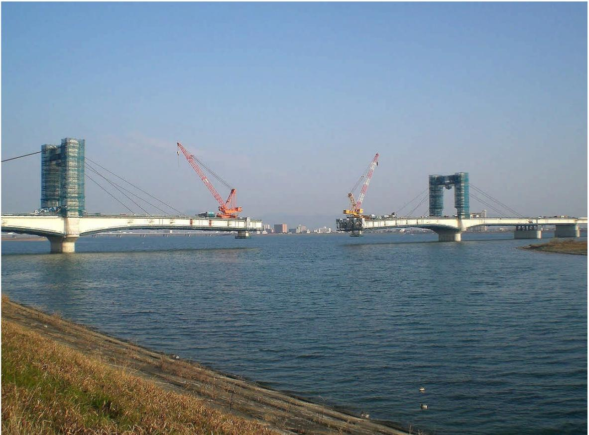
写真 13 (干潟部 P2~P3 間) 中央径間張出し架設 (第 2 架設ケーブル支持状態)
