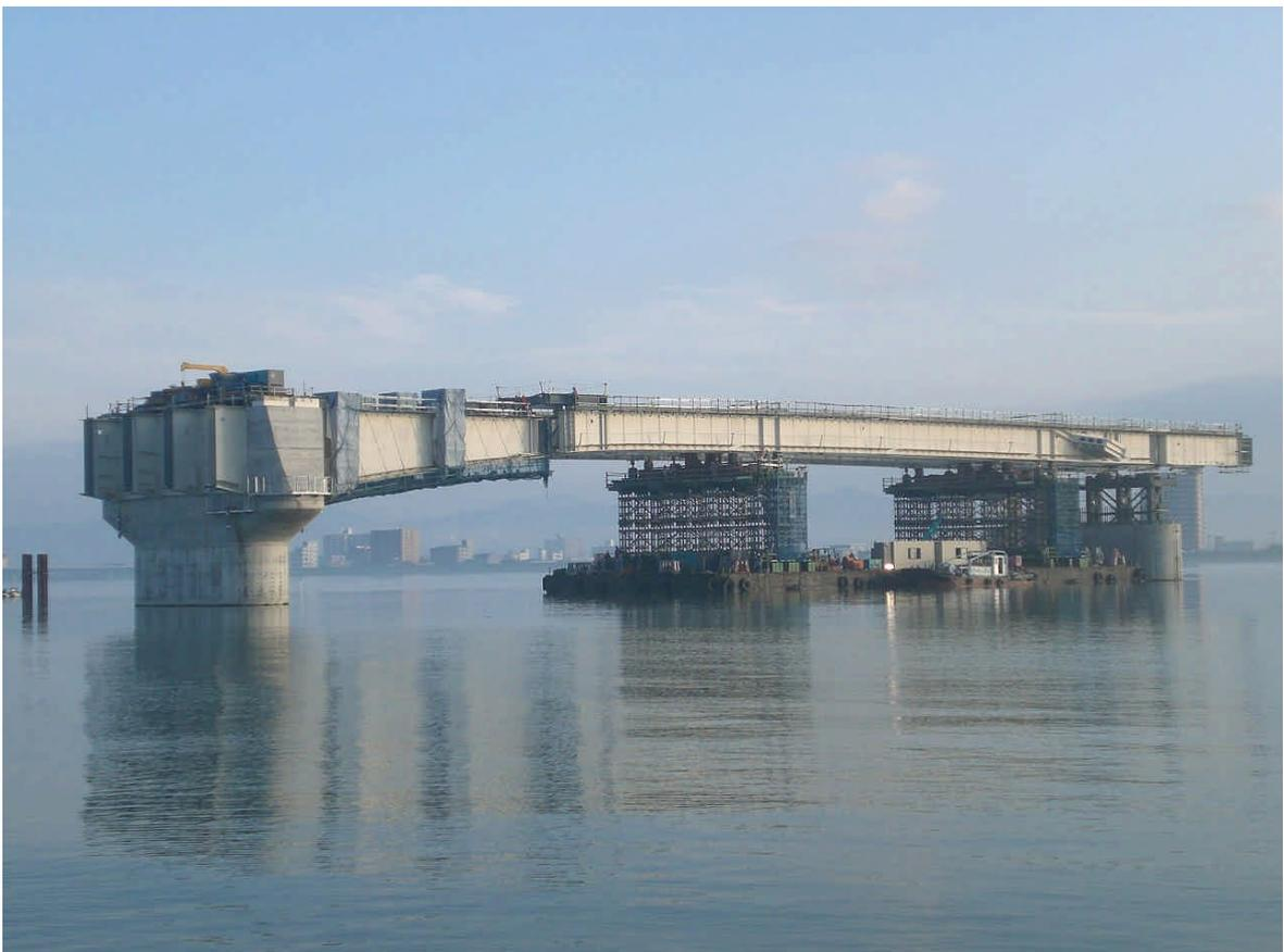
写真 17 (干潟部 P3~P5 間) 大ブロック (L=95m) 台船一括架設
