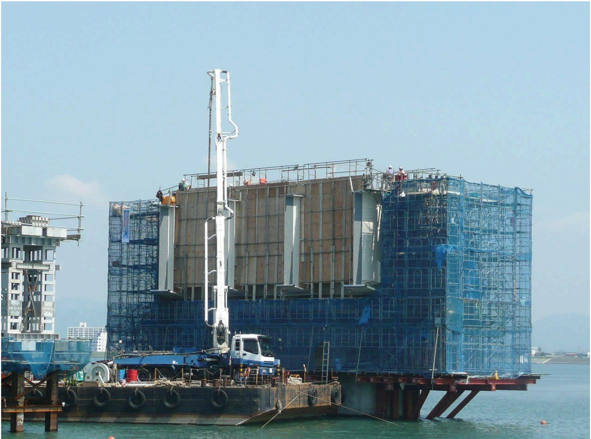
写真10 (干潟部 P2 剛結部) 堤防からの配管にて剛結部コンクリート打設
