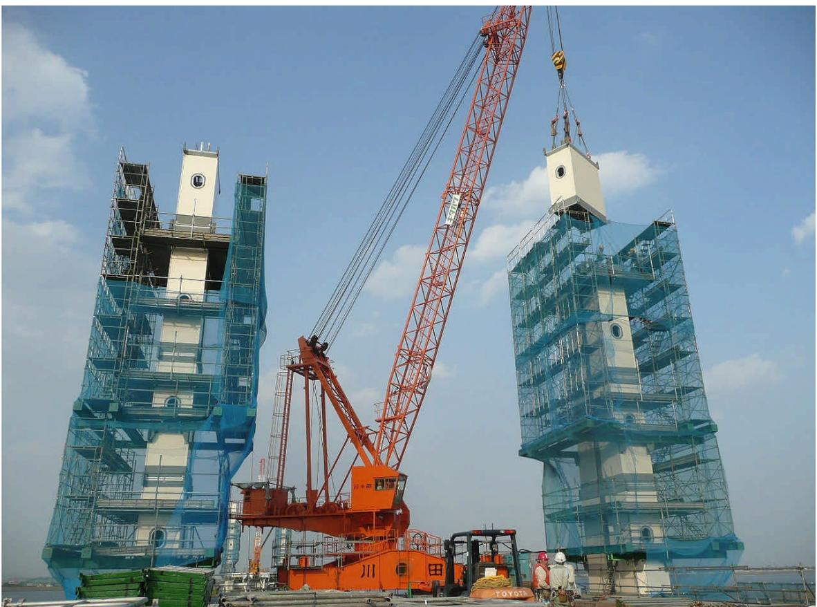
写真11 (干潟部 P2 主塔) 主塔ブロック建込み (トラベラークレーン架設)
