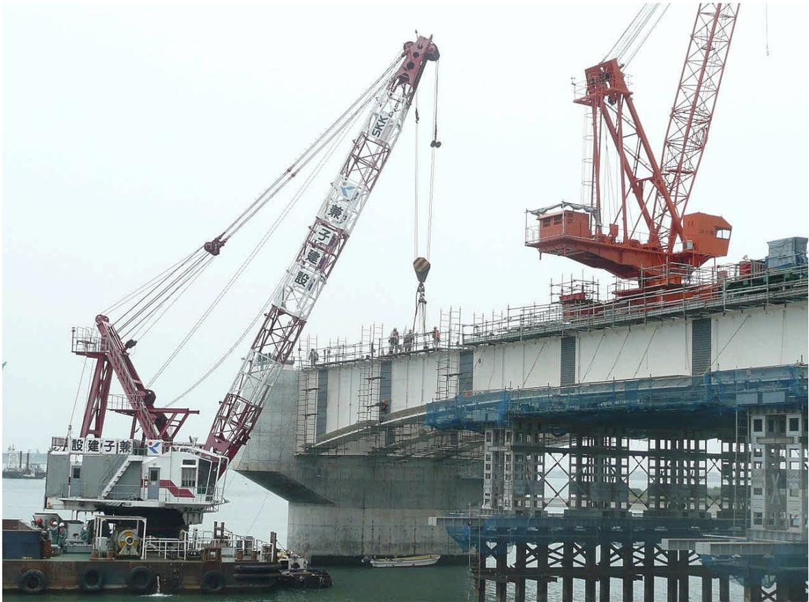
写真6 (干潟部 P1~P2 間) J11~J13 主桁ブロック FC 架設 (側径間閉合)
