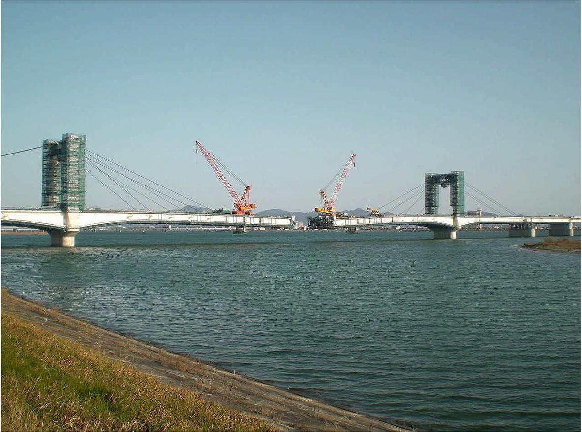
写真 14 （干潟部 P2～P3 間）中央径間張出し架設（第 3 架設ケーブル支持状態）
