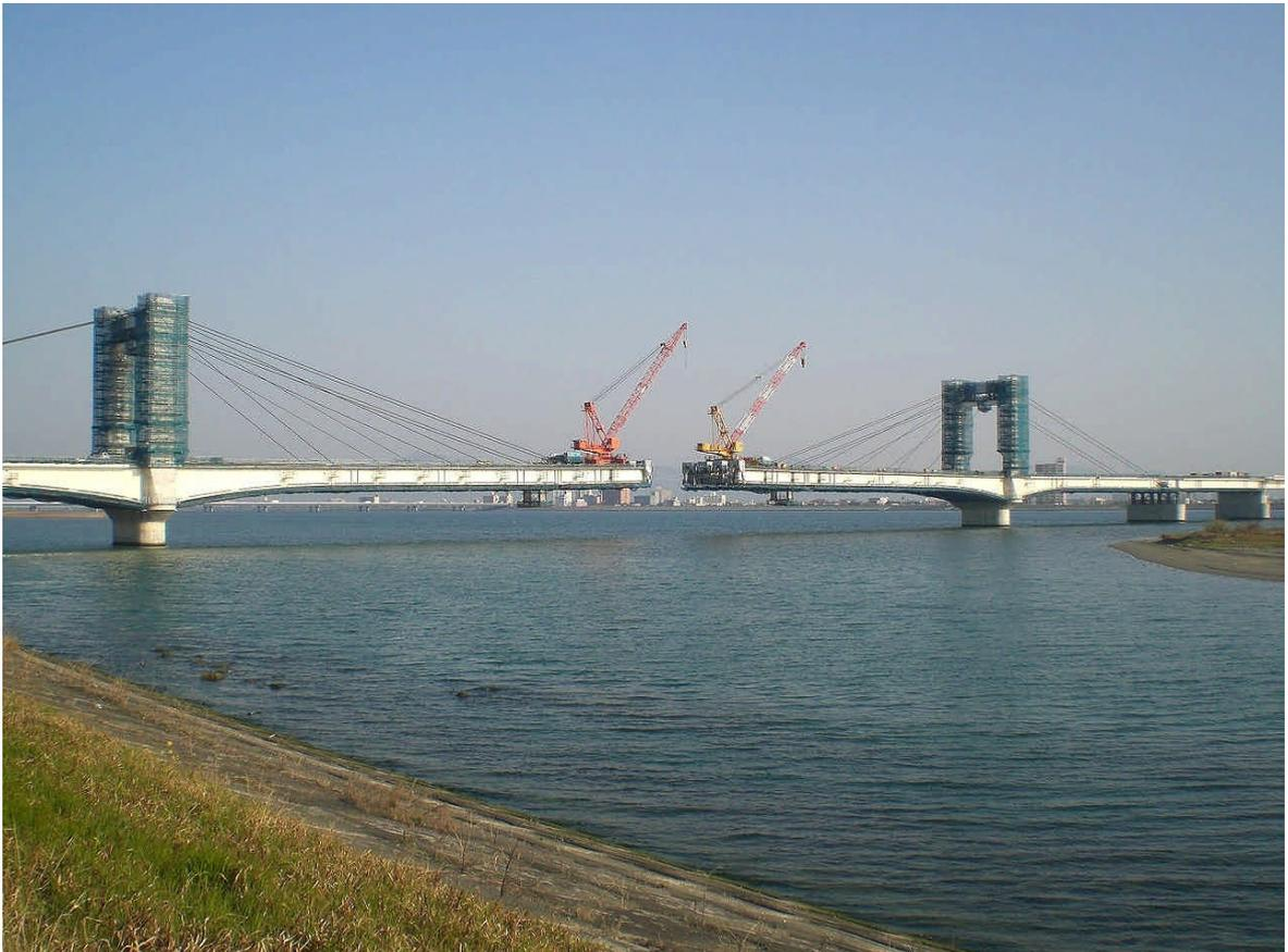
写真 15 （干潟部 P2～P3 間）中央径間張出し架設（第 4 架設ケーブル緊張後）
