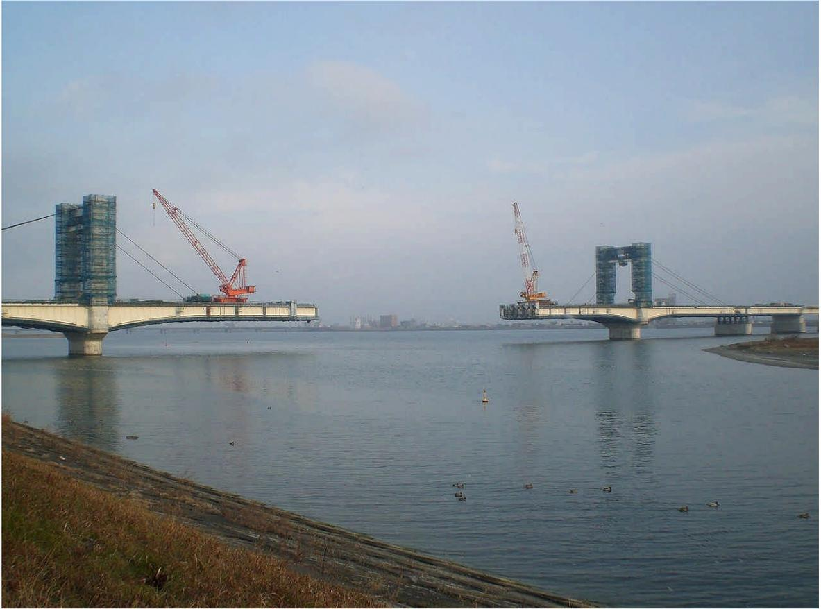
写真 12 (干潟部 P2~P3 間) 中央径間帳出し架設 (バック・第 1 架設ケーブル支持)
