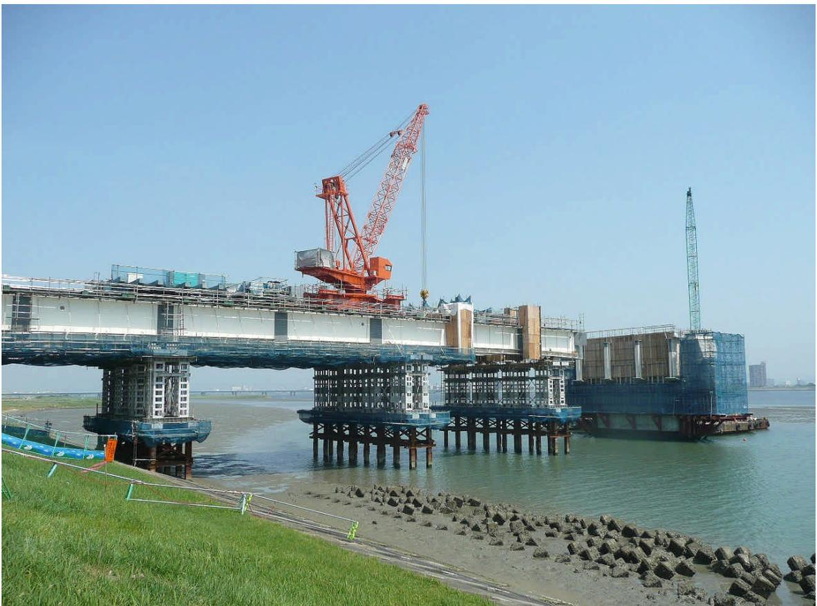
写真5 (干潟部 P1~P2 間) J9~J11 トラバークレーンベント架設
