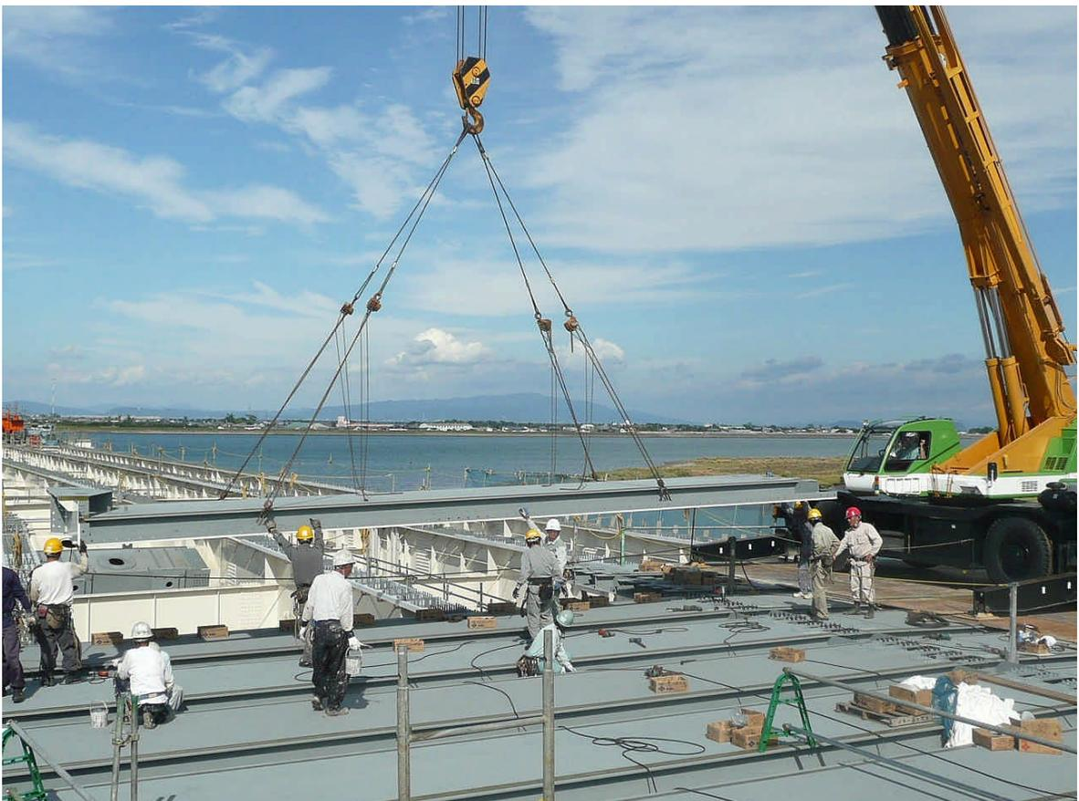
写真7 (干潟部 P1~P2 間) 側径間 サンドイッチ床版敷設
