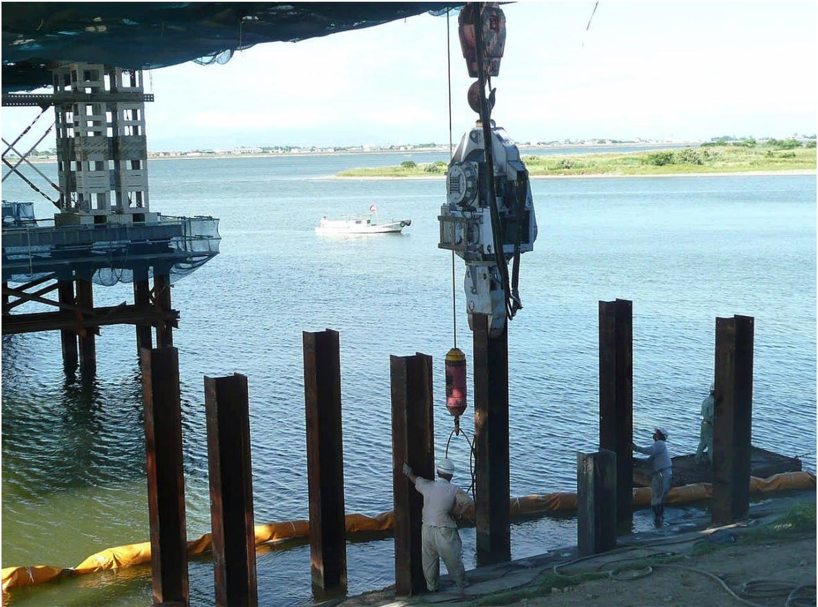
写真8 (干潟部 P1~P2 間) バイブロハンマによる B5 ベント杭の引抜き
