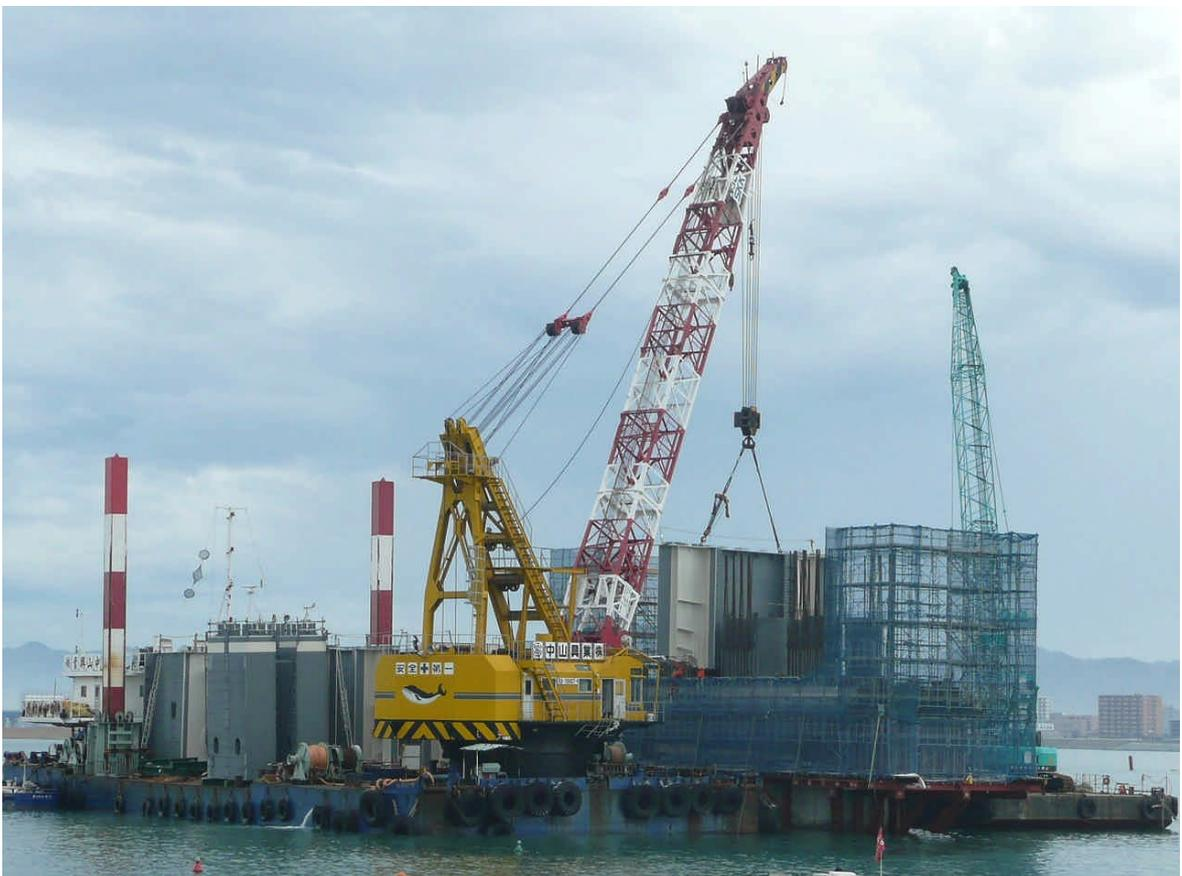
写真9 (干潟部 P2 剛結部) 剛結部主桁ブロックを FC にて架設
