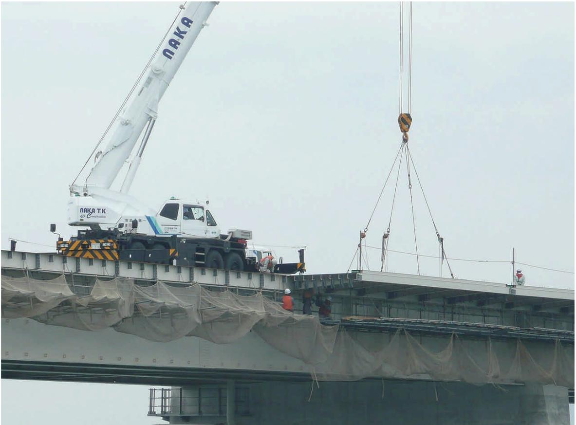
写真3 (一般部 P10~A2) 鋼床版ブロック ラフタークレーン架設
