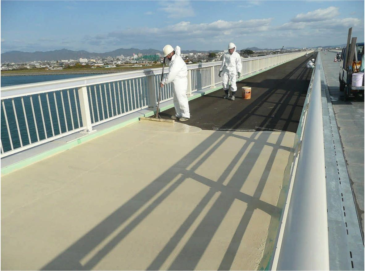
写真4 (一般部 P10~A2) 歩道舗装 表層塗装工
