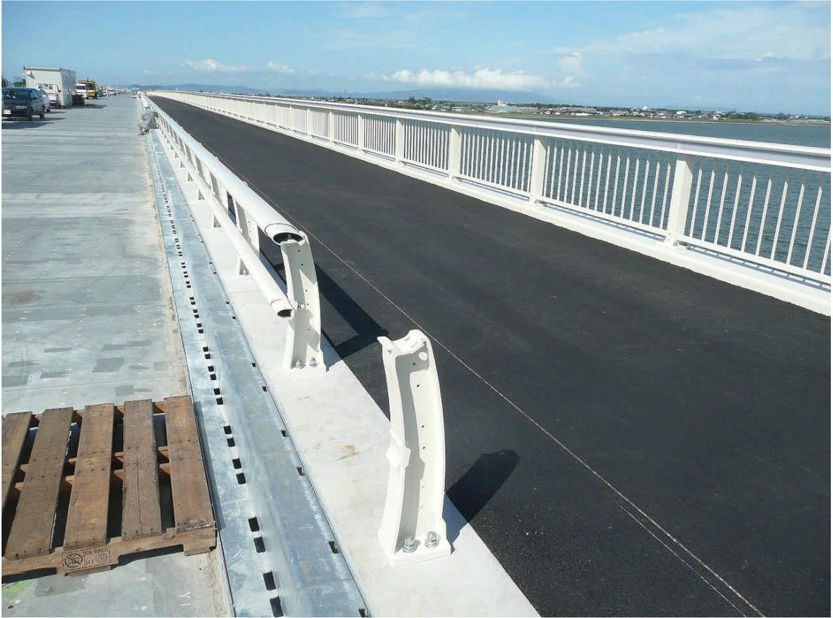
写真2 (一般部 P5~P10) 歩車道境界防護柵・照明内蔵高欄の設置
