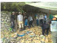
高開石積みの修復作業
