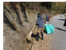
集落道の整備作業 (美馬市脇町)
