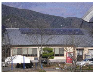
太陽光パネル設置施設
