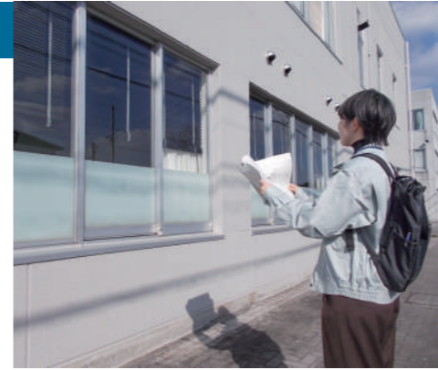
▼ 現場確認の様子
