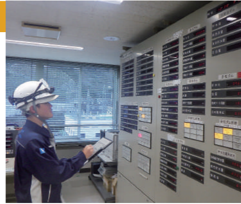
▼ 巡視点検作業
