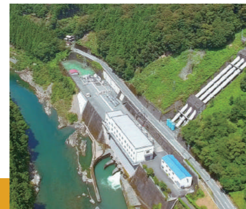
▲ 日野谷発電所
