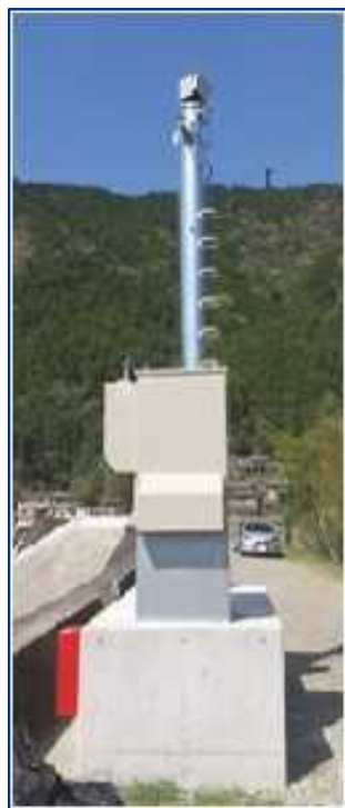
河川付近にローカル5G 基地局設備を設置
