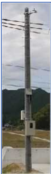
河川付近にローカル5G 基地局設備を設置
