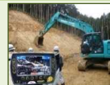
ICT活用工事
