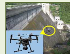
ドローンを活用したダム設備点検
