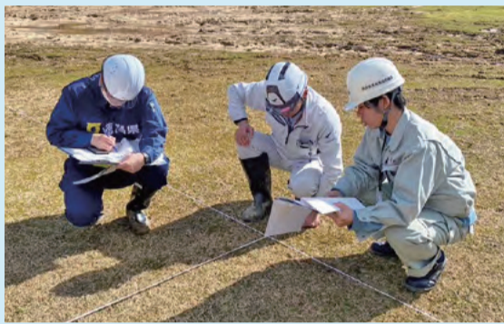
地縄検査状況(建物の配置確認)
