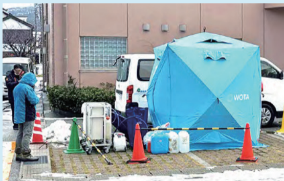
シャワーキットの設置を準備しているところ
