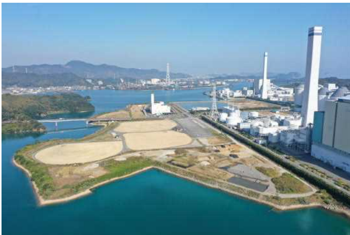
橘港小勝・後戸地区
