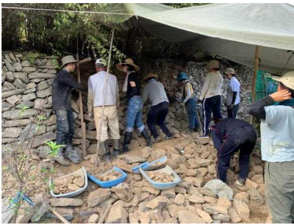
棚田の保全・活用 (棚田の石積み修復作業)
