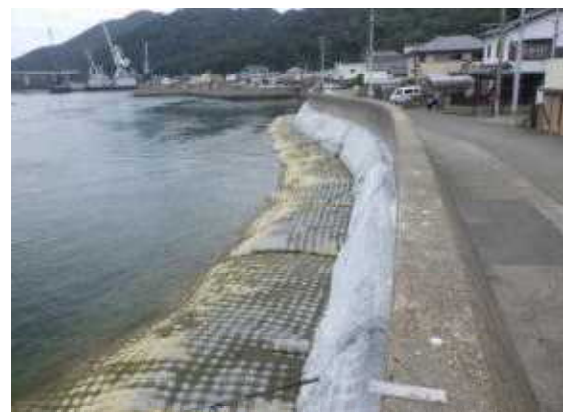
漁港海岸・護岸補強 （鳴門市土佐泊漁港海岸）整備後
