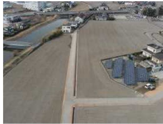
ほ場整備（阿南市芳崎地区）整備後
