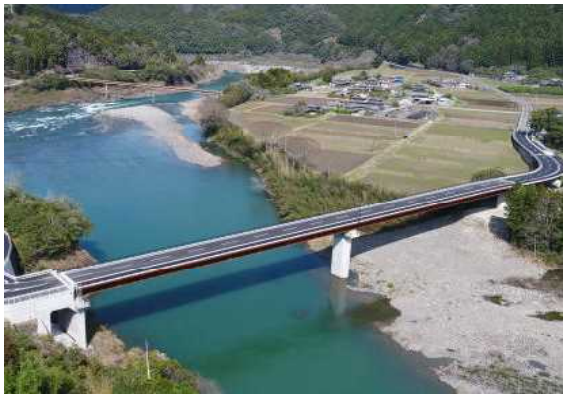
緊急輸送道路を補完する農道 （那賀町 阿南丹生谷地区）
