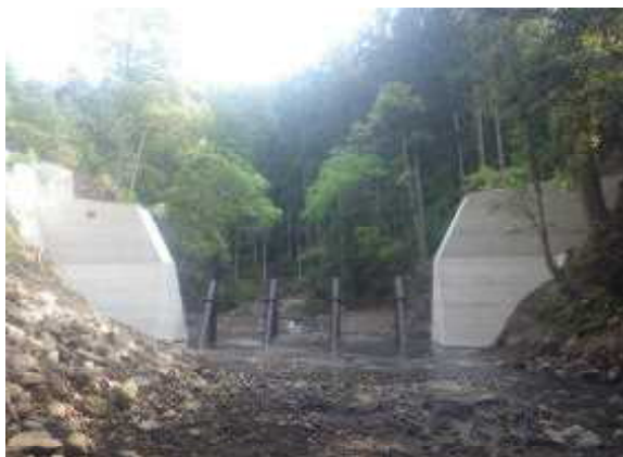
流木捕捉式治山ダムの設置 (海陽町大又地区)
