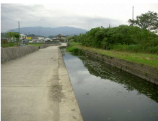
直線化された水路
