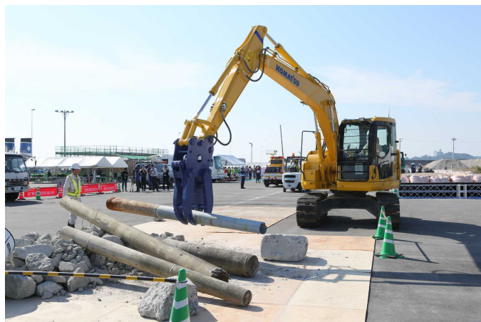
写真 ガレキ除去訓練状況
