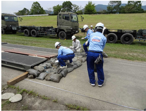
写真 土のうによる段差解消訓練
