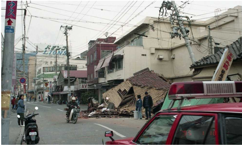
写真 電柱の破損事例
