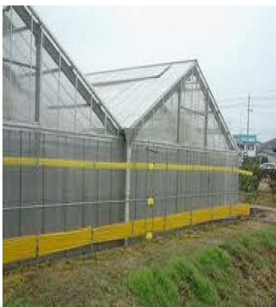
ハウス外の設置事例③
