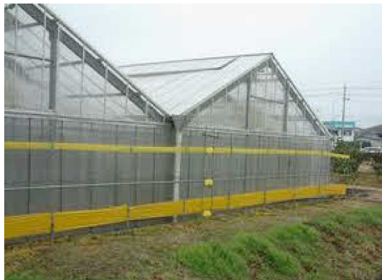
ハウス外の設置事例④
