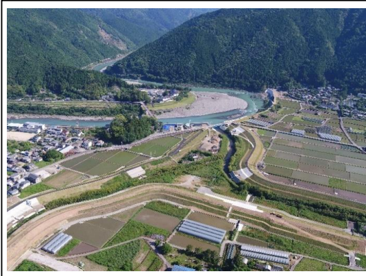
那賀川床上浸水対策特別緊急事業(和食・土佐地区) 河川堤防 令和2年度完成
