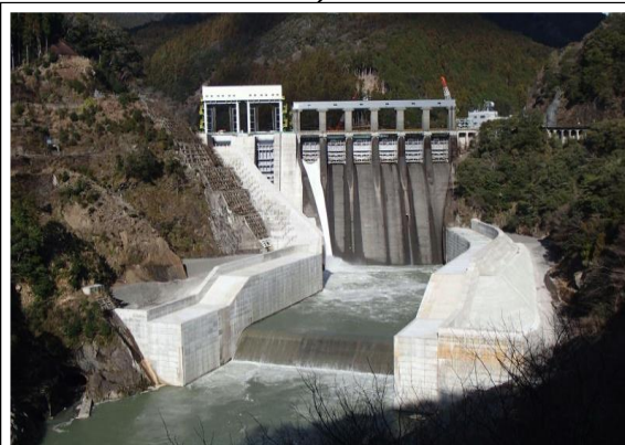
長安口ダム改造事業 新設洪水吐ゲート 令和元年度より運用開始
