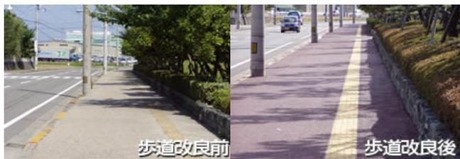
上と同じように、透水性舗装の採用と点字ブロックとの色彩の明確化を図りました。
