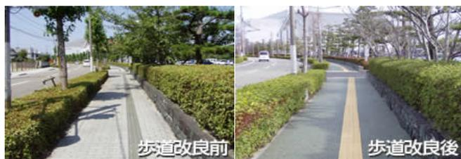
改良前は同一色の歩道ブロックと点字ブロックでしたが、改良により透水性舗装の採用と色付き点字ブロックの採用により、視認性の向上と雨天時の歩道の安全性が向上しました。
