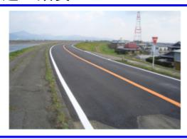
一見,普通の舗装路ですが,ラインに非リブ式高視認性路面標示を採用しており,雨天時の視認性がよくなることにより,ドライバーの安全性が向上しました。 (平成20年度施工)
