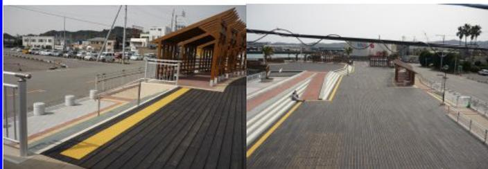
ウッドデッキの端には点字ブロックを配置し、目の不自由な方に段差があることを伝えるようにしています。また、横断方向の移動のためにスロープを設けることで、陸川から海側への移動が誰でも容易に行えるよう配慮しました。
