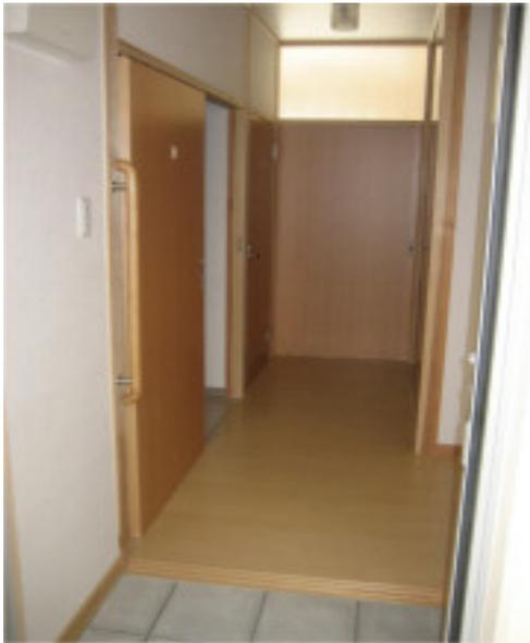
玄関の土間と廊下の段差は極力段差がなくなるように施工しました。これにより、車いすの方でも室内に容易に入ることができます。
