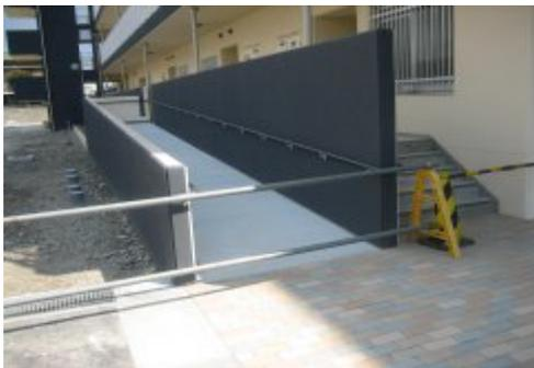
入口は通常の階段に加え、スロープを設けました。傾斜も緩くして、車いすの方が登りやすいようにしています。
