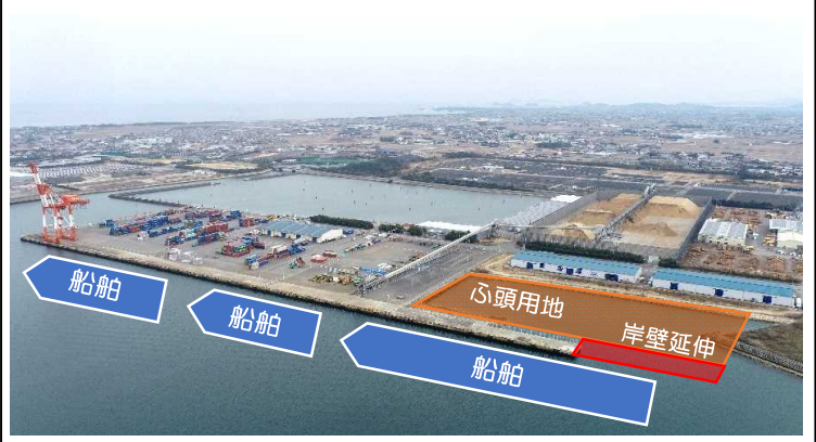
徳島小松島港赤石地区 港湾機能強化（船舶の大型化等に伴う岸壁延伸）の推進
