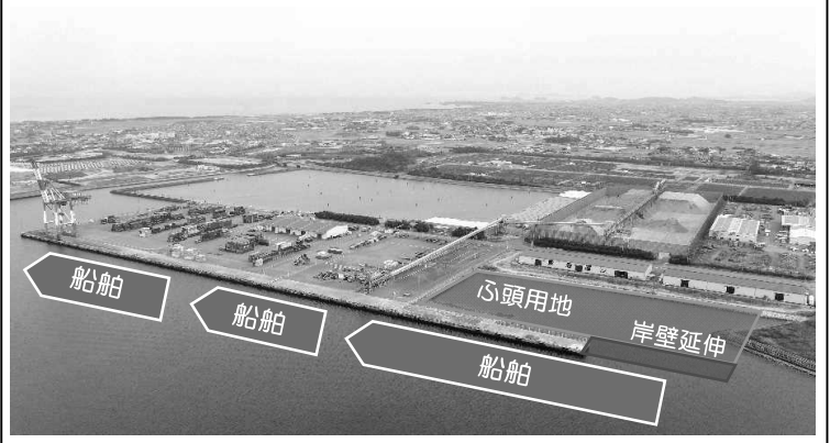
徳島小松島港赤石地区 港湾機能強化（船舶の大型化等に伴う岸壁延伸）の推進
