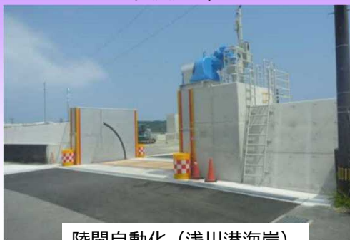
陸閘自動化（浅川港海岸）
