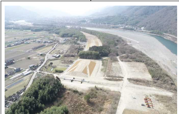
吉野川（加茂第二箇所） 堤防整備を促進
