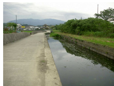
直線化された水路
