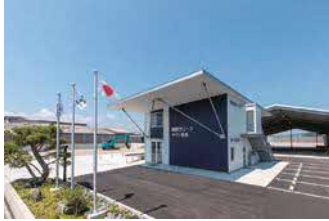
(有)ヤマト重機 徳島営業所
