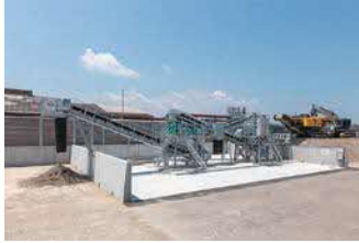
中間処理施設
