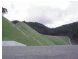
吹き付け工法
