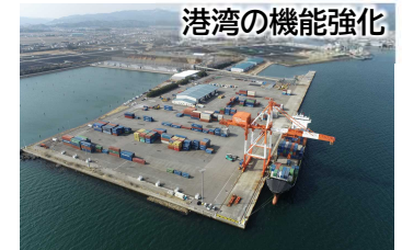
港湾の機能強化 徳島小松島港 赤石地区 (小松島市)
