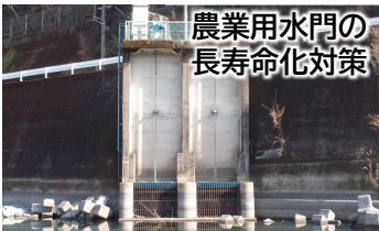
農業用水門の長寿命化対策 海部川沿岸地区 (海陽町)
