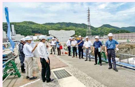
徳島南部自動車道 阿南インターチェンジ
