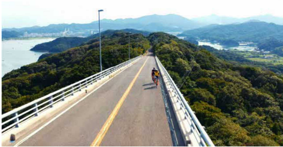
鳴門スカイライン (鳴門市)
