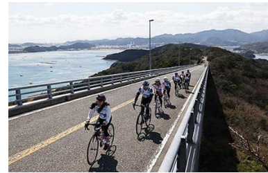
鳴門スカイライン（四方見橋）
