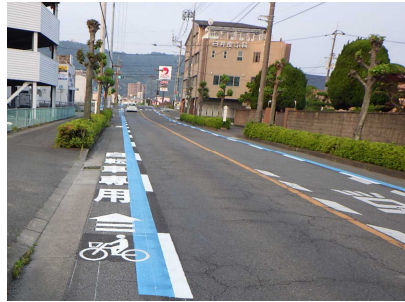
自転車専用通行帯整備状況 (徳島市道 北佐古・田宮春日線)
