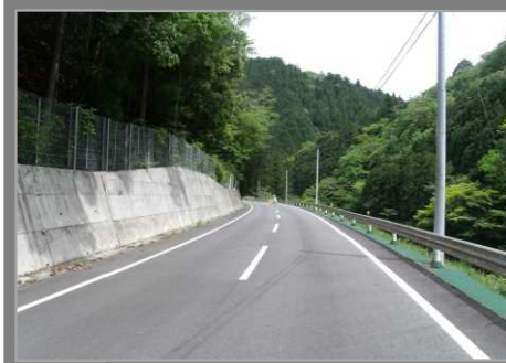
現道拡幅区間 L=90m (H21.3月部分供用)
