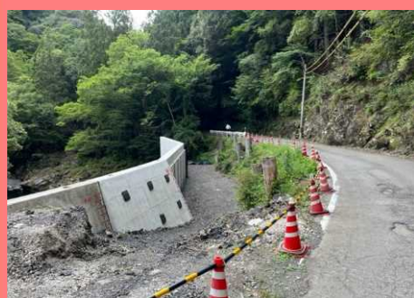
現道拡幅区間 L=80m (R1~ 施工中)
