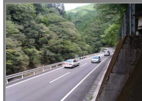
現道拡幅区間 L=330m (H21.3月部分供用)
