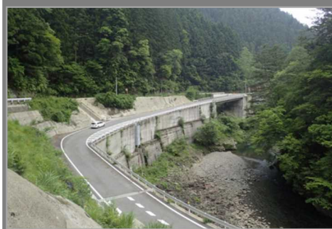
海川1号トンネル終点側 坑口付近 L=270m (H27.3月部分供用)
