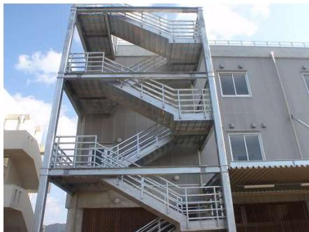
▲研究防災棟には発災時に屋上に避難するための階段が設置されています。キュービクル、自家発電装置、冷蔵庫は、発災時に稼働できるよう3階に設置されています
