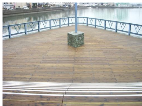
徳島すぎのウッドデッキ (アスティとくしま)
