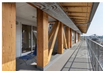
あわらし木造の準耐火構造 ＜提供：笹の倉舎／笹倉洋平＞
