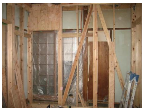
県産材による耐震改修
