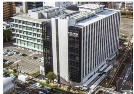
新防災センター「徳島中央警察署」 新庁舎供用開始
